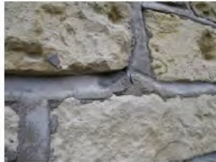
Mur en moellon de pierre calcaire (pierre de Jeumont)
